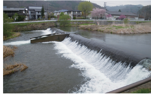
写真-4 米内川合流部直下の取水堰と魚道
