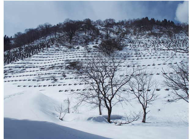
写真-4 予防杭によって斜面積雪が安定している様子
