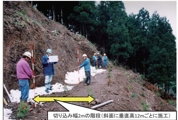
写真-2 切取階段工(完成検査時の状況)
