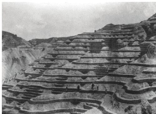
1903年時点の積苗工の施工状況
