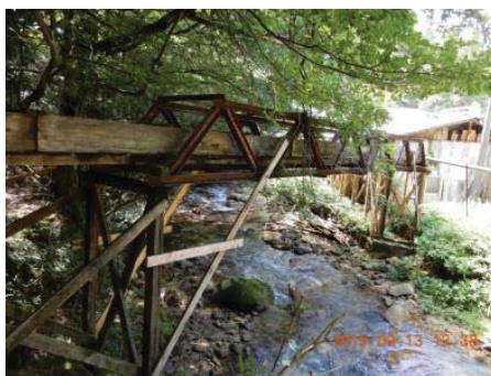
梶並川からの取水施設
